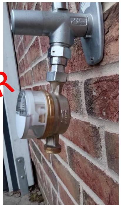
3 Kontrolle der Fließrichtung, Seitenansicht
