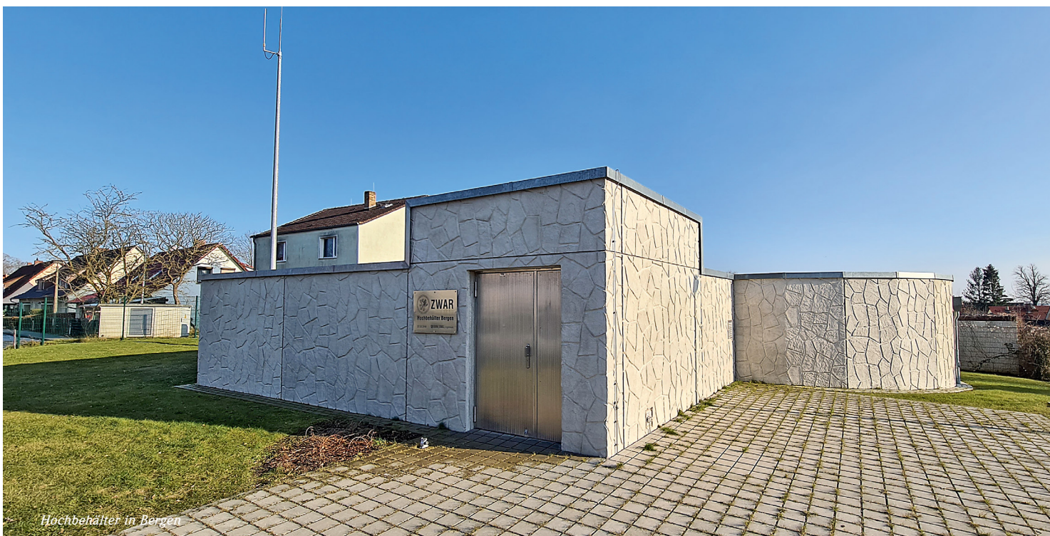
Hochbehälter in Bergen
